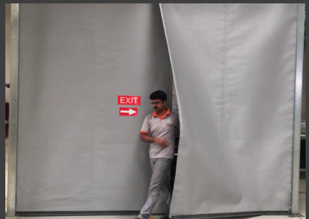
Egress allows safe passage
